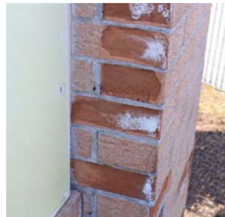
danni di un trattamento non traspirante
